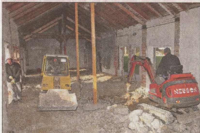
Schwere Maschinen sind zurzeit Am Exer im Einsatz.
